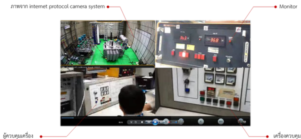
ภาพตัวอย่าง FACTORY ACCEPTANCE TEST : FAT โดยระบบตรวจรับหม้อแปลงไฟฟ้าผ่านระบบ กล้องอินเทอร์เน็ตโปรโตคอล INSPECTION WITNESS SYSTEM OF POWER TRANSFORMER VIA INTERNET PROTOCOL CAMERA SYSTEM
