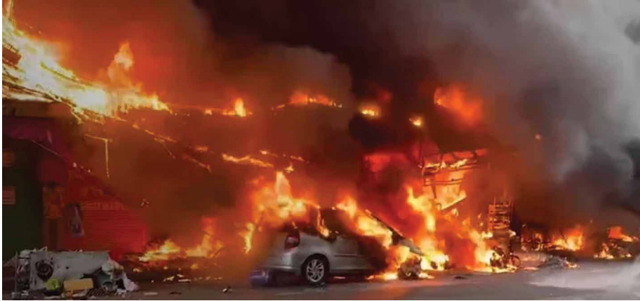
รูปที่ 4 หม้อแปลงไฟฟ้าระบบจำหน่ายเกิดไฟไหม้สร้างกลุ่มควันที่เป็นมลพิษต่อสิ่งแวดล้อม
