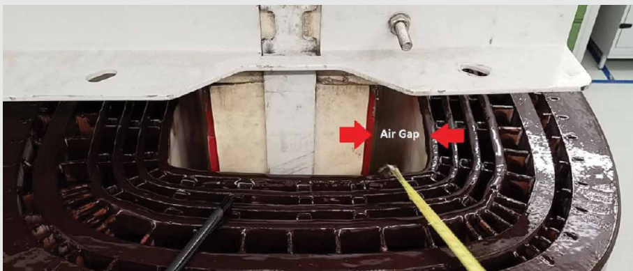
รูปที่ 3 ภาพแสดงช่องอากาศระหว่างแกนเหล็กกับขดลวด Dry Type
