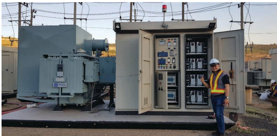
รูปที่ 9 ระบบสตาร์ทและควบคุมมอเตอร์ 1,400 kW / 6,600 V สำหรับระบบสูบน้ำที่ใช้ในการทดสอบ
