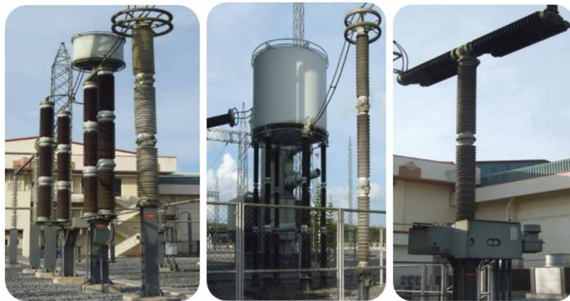
รูปที่ 19 - DC Measuring Device, DC Filter, DC Breaker
