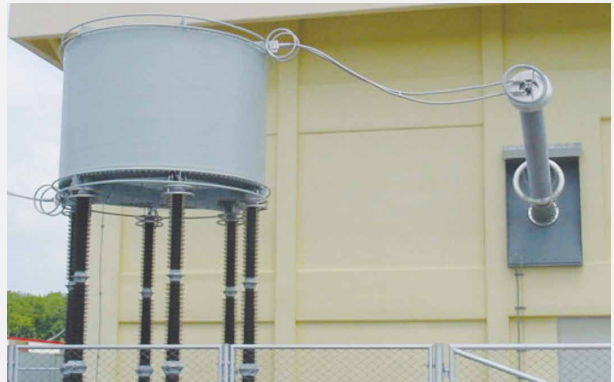
รูปที่ 15 - อาคาร Valve Hall
