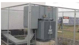
หม้อแปลงดับเรื่อง : หม้อแปลงไฟฟ้ากริดไทย ขนาด 1000/500/500 kVA 3 Ph 22000 – 300/300 V จำนวน 1 เครื่อง หมายเลขเครื่อง 5612314 จำหน่ายและใช้งานที่ : บริษัท ฟ้ายัย วิศวกรรม จำกัด โครงการ Solar Rooftop at Homepro เขาใหญ่ จังหวัดนครราชสีมา
