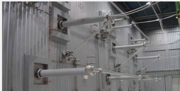
รูปที่ 17 - Converter Transformer
