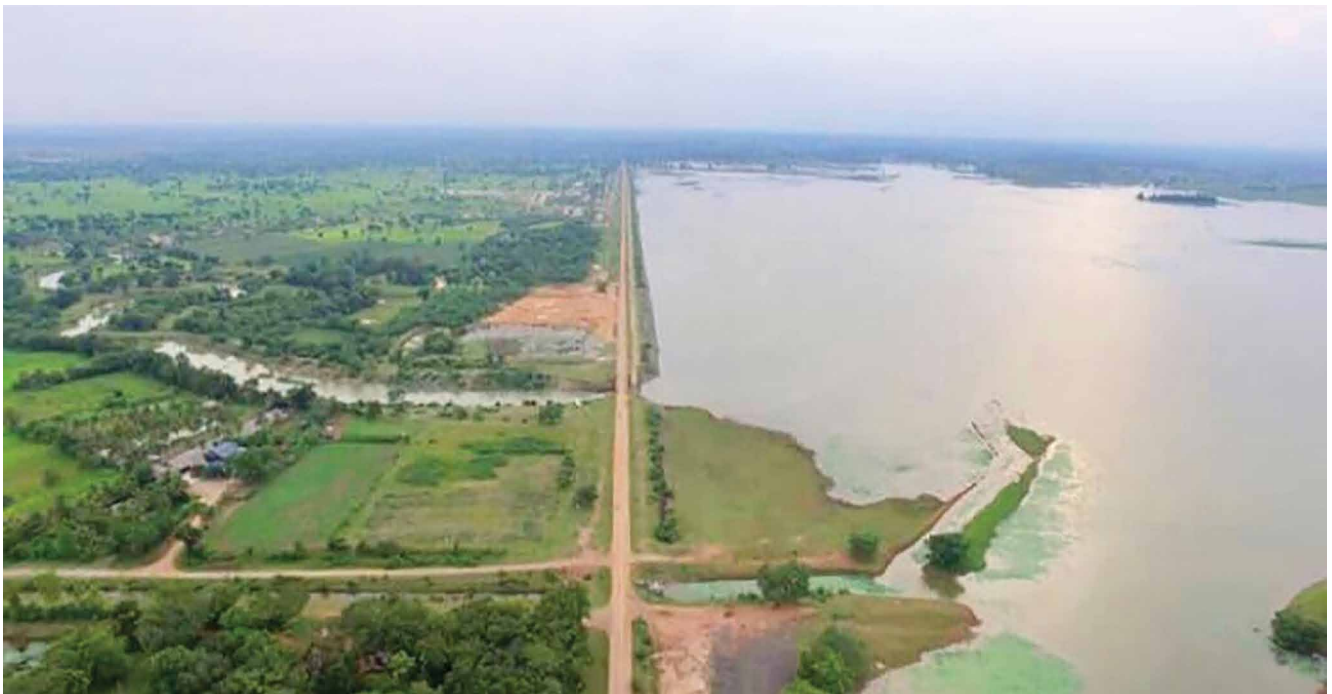
อ่างเก็บน้ำลำเชียงไกร
