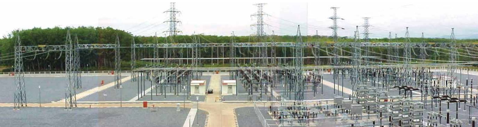
รูปที่ 5 - สถานีไฟฟ้าแรงสูงคลองแวง
