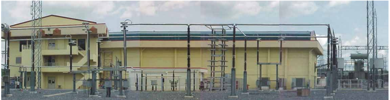
รูปที่ 18 - DC Switchyard
