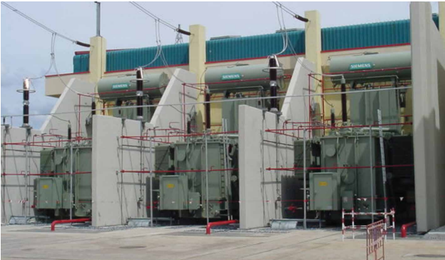
รูปที่ 14 - Converter Transformer
