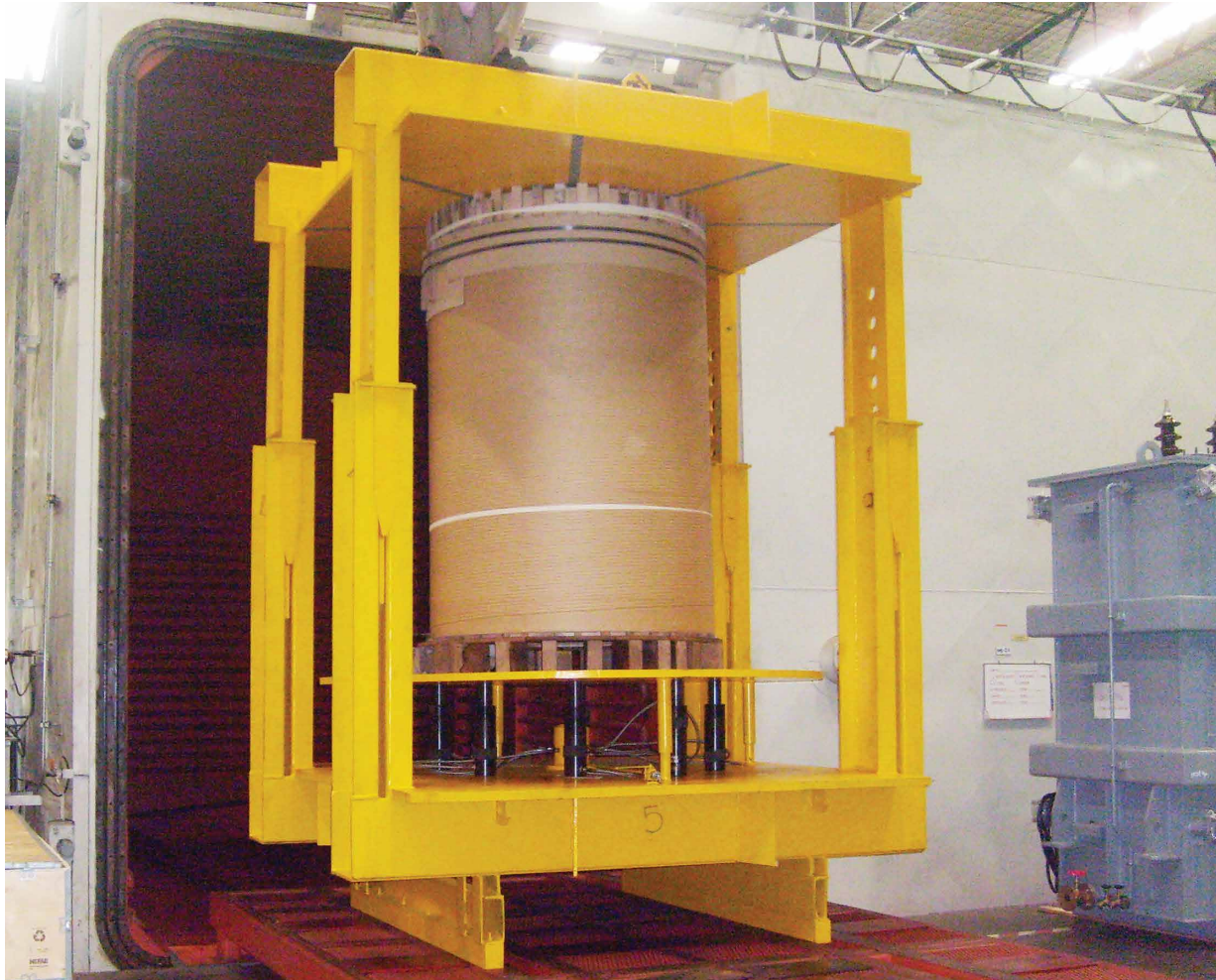
เตาอบไล่ความชื้น ระบบ Vapors Phase
