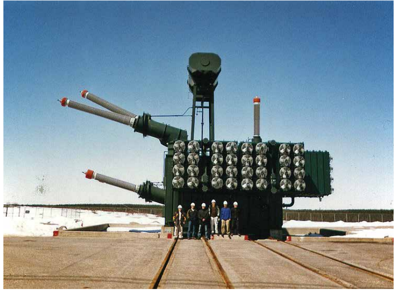
ภาพแสดง single-phase, three-winding converter transformer
