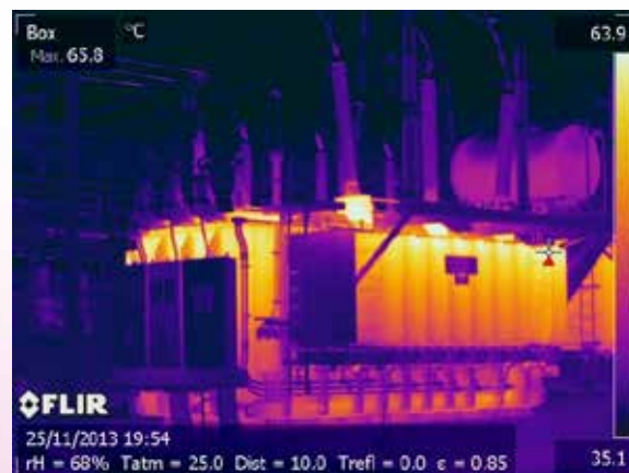
รูปที่ 4 แสดงการตรวจสอบค่าความร้อนที่ ครีบริบายความร้อน
