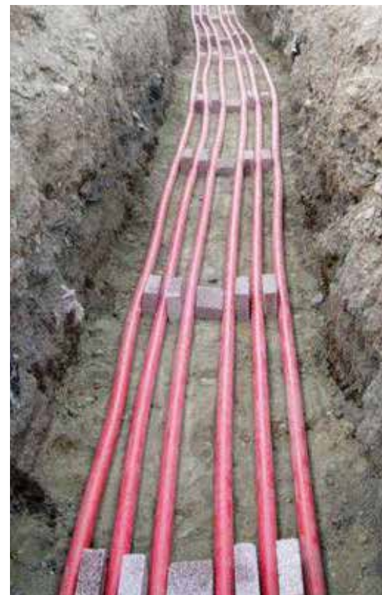
รูปที่ 4 สายส่งระบบ 3 เฟสที่ขนานกันจำนวน 2 ชุด
