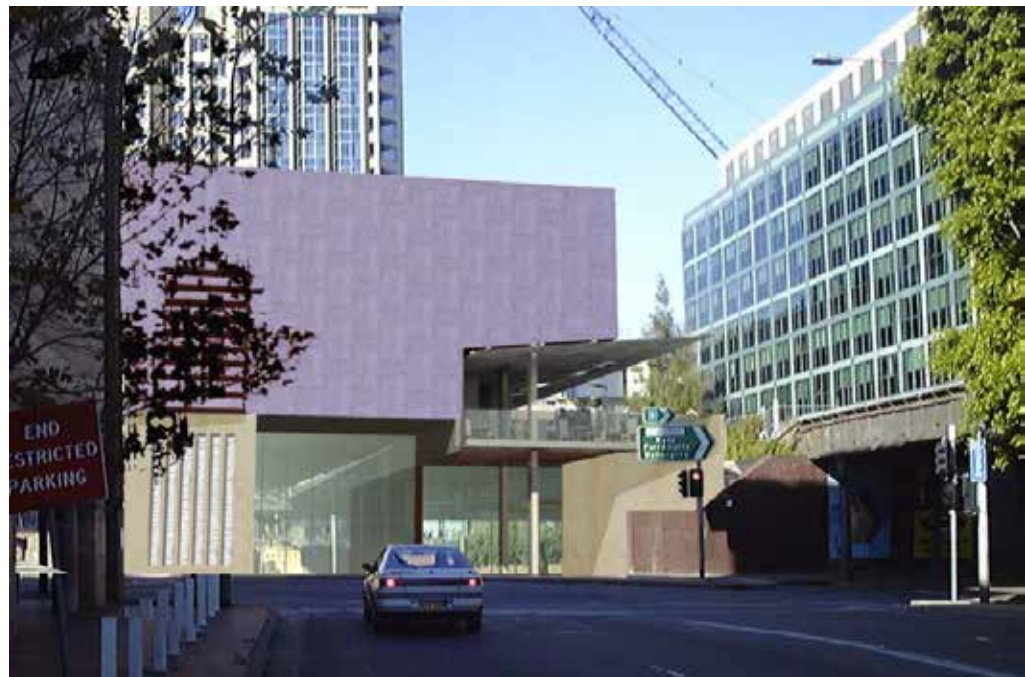
รูปที่ 2 อาคารสถานีไฟฟ้า Haymarket
