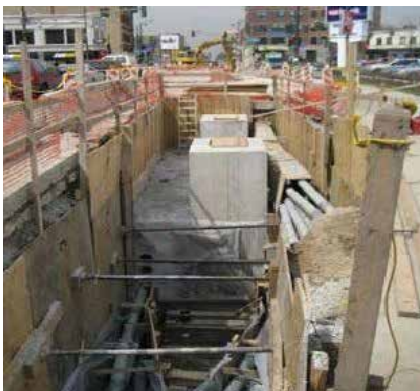
รูปที่ 6 การก่อสร้างห้องใต้ดินสำหรับสายเคเบิล
