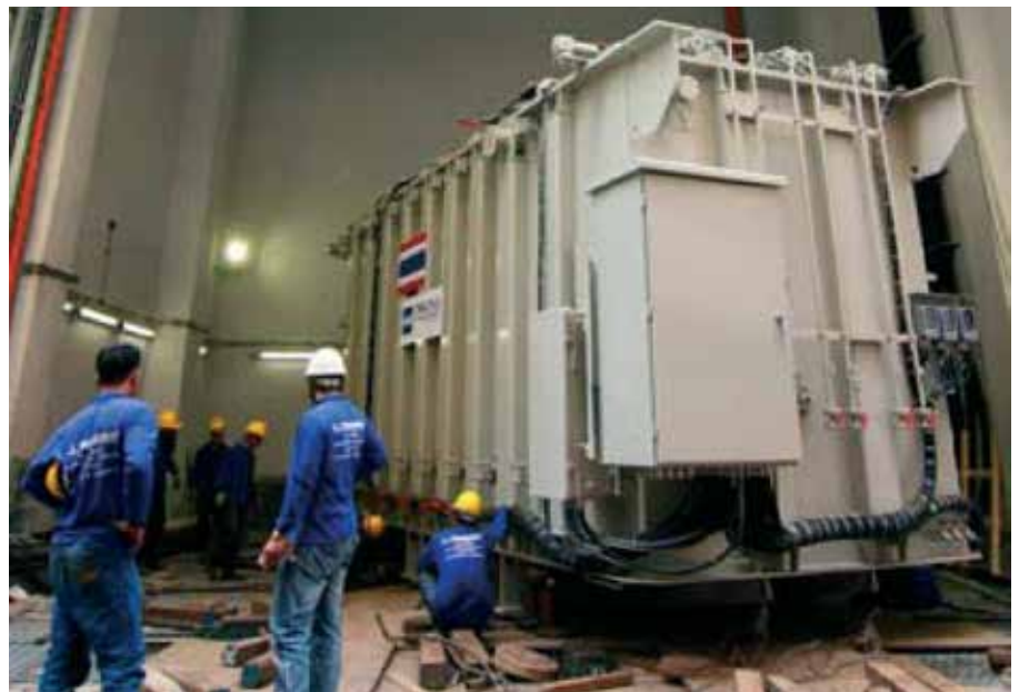
ภาพติดตั้งหม้อแปลง
