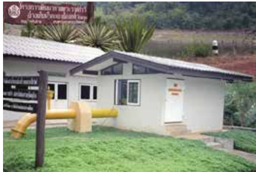
รูปที่ ๑๐. โรงไฟฟ้าพลังน้ำ คลองช่องกล้า จ.สระแก้ว
