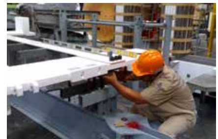
ภาพการตั้ง Clamp และตรวจสอบระดับ
