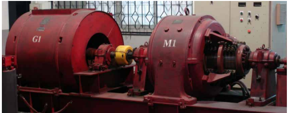
รูปที่ 7. แสดง Motor-Generator Set
