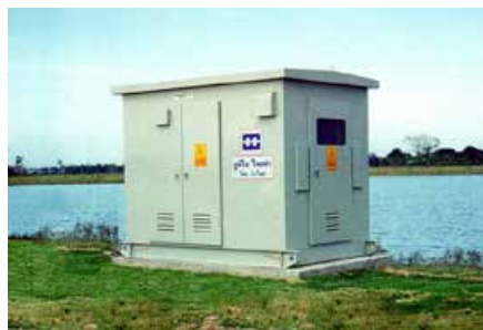
หม้อแปลงชนิด Power Unit Substation
