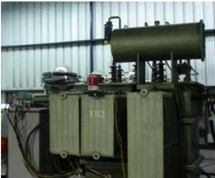
รูปที่ 4. แสดงหม้อแปลงช่วยทดสอบ (Auxiliary Transformer)
