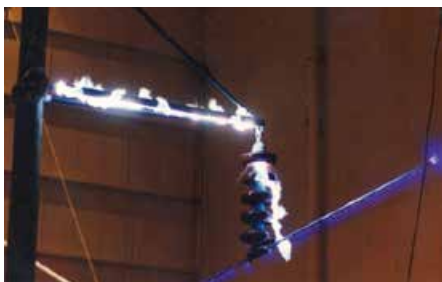
รูปที่ 1: แสดงการเกิด Flashover ลูกถ้วยฉนวน
