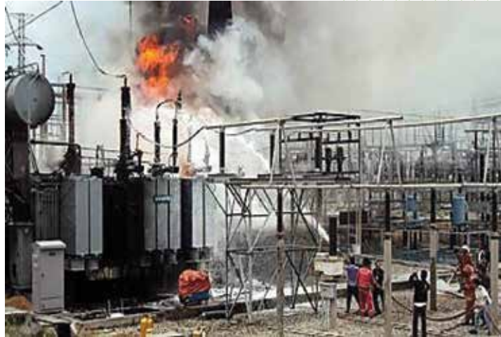
รูปที่ 1 ความเสียหายของหม้อแปลงที่โรงไฟฟ้า
