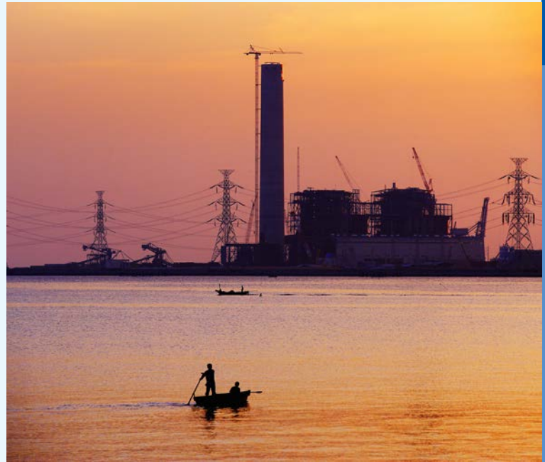
โรงไฟฟ้าบีแอลซีพีช่วงทอสร้าง
