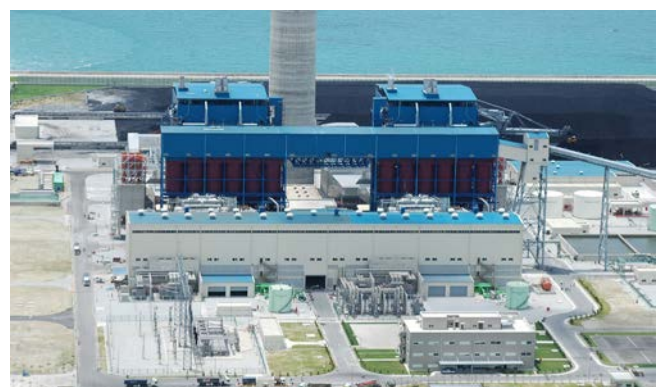
➡ อาคารผลิตไฟฟ้า
