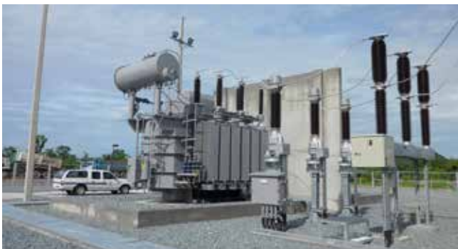
▶ หม้อแปลงไฟฟ้า Mobile Substation ขนาด 15/20/25 MVA 115 kV
