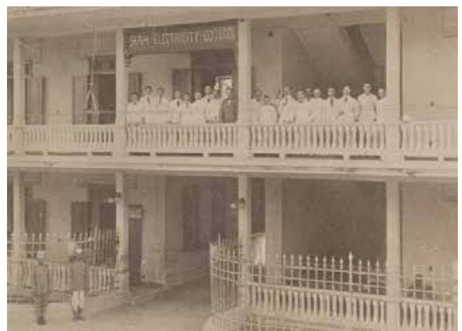
▲ บริษัท ไฟฟ้าสยาม จำกัด ในปัจจุบันคือการไฟฟ้านครหลวง (วัดเลียบ)
