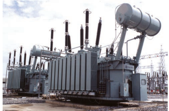
หม้อแปลงไฟฟ้ากำลัง ขนาด 300 MVA 230 kV ติดตั้งที่สถานีไฟฟ้าแรงสูงบางกอกน้อย การไฟฟ้าฝ่ายผลิตแห่งประเทศไทย
