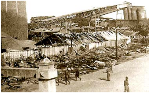
โรงไฟฟ้าวัดเลียบ และวัดเลียบเสียหายจากการถูกโจมตีทางอากาศ
