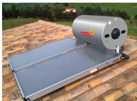
(ก) แผงรวมความร้อนแบบแผ่นเรียบติดตั้งบนหลังคา
