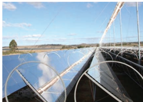
รูปที่ 12 ระบบเครื่องสะท้อนแสงเชิงเส้นฟริสเนล
