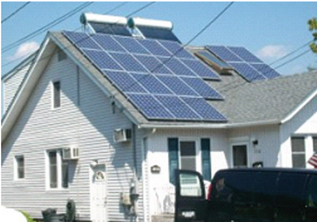
(ข) แบบมุมคงที่ติดตั้งบนหลังคา
