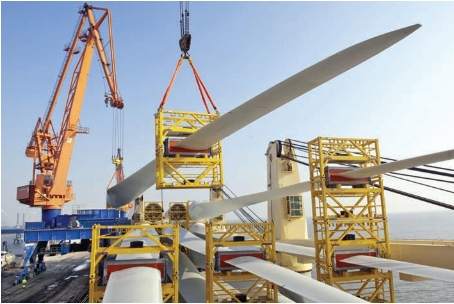
รูปที่ 3 การยกใบพัดโรเตอร์เพื่อ การติดตั้งบนกังหันลมผลิตไฟฟ้า นอกชายฝั่ง
