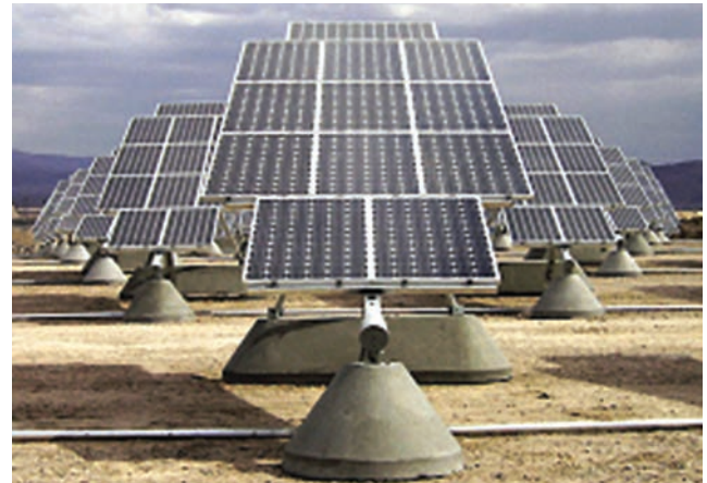
(ค) แบบหมุนตามดวงอาทิตย์ติดตั้งบนพื้นดิน
