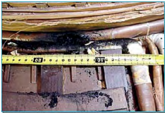
รูปที่ 6 การเกิดดิสชาร์จบางส่วนในหม้อแปลง
