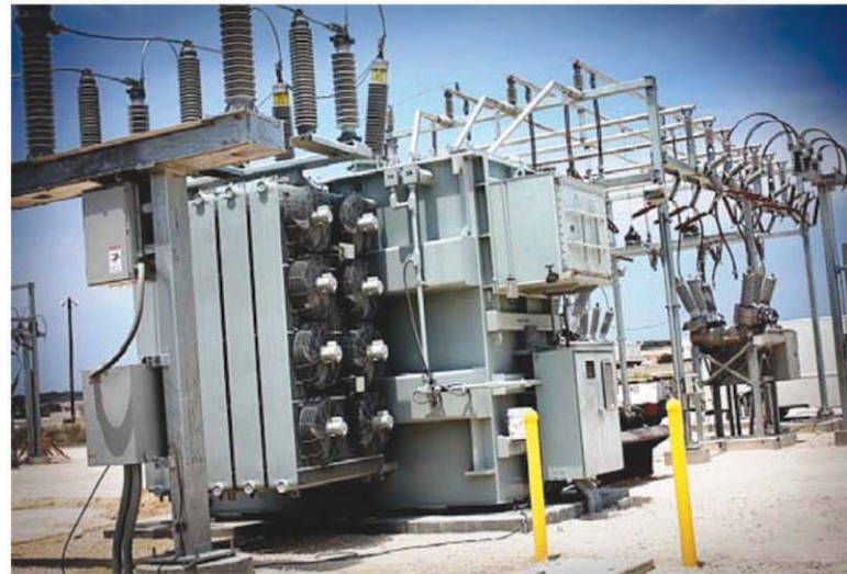
รูปที่ 1 หม้อแปลงกำลังติดตั้งในสถานีไฟฟ้าย่อย
