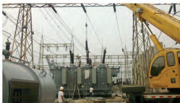
ภาพการติดตั้งหม้อแปลง
