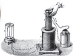
วงจรการทดลองการเหนี่ยวนำของขดลวดของฟาราเดย์
